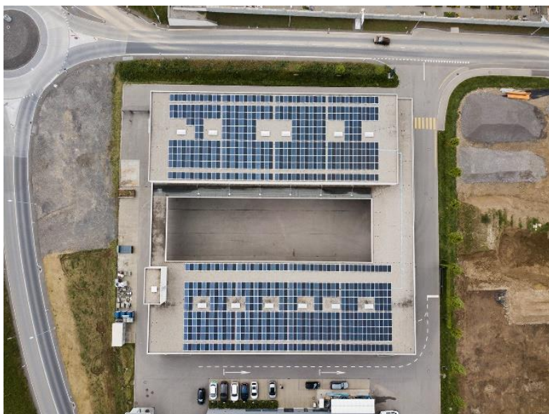
Bildlegende: Die grossflächige Anlage auf dem Dach des Werkhofs deckt mit rund 900 Panels den Strombedarf von 50 Haushalten.
